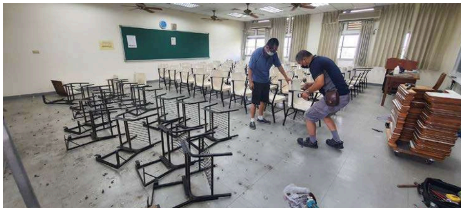
▲師傅認真的進行桌椅拆遷作業
